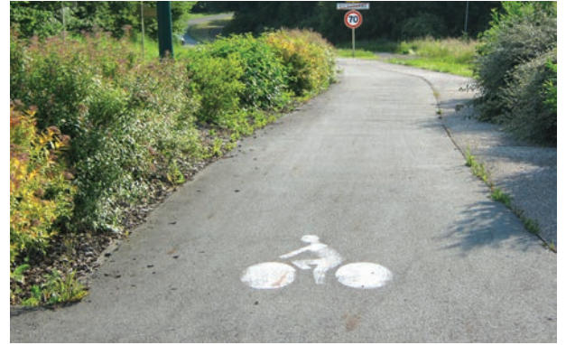
Réfection chemin piétonnier Route de Dung
